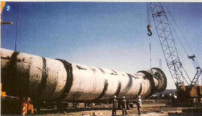
◎ 海底管線安裝工程： Submarine Pipeline Laying:
