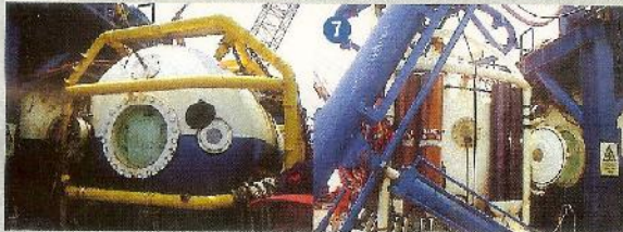
⑦ 國光1號(CBK11)、2號(CBK12)、3號(CBK13)鑽油平台拆除工程： Demolishing of Oil Drilling Platform CBK11, CBK12 and CBK13:
